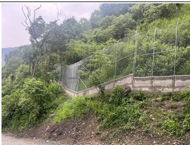
Foto 17: ejemplo de protección de taludes y cerramiento, en las obras de captación de la PCH Chorreritas
